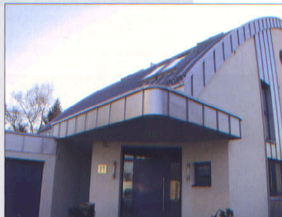
Tonnendacheindeckung mit Aluminiumprofilblechen
