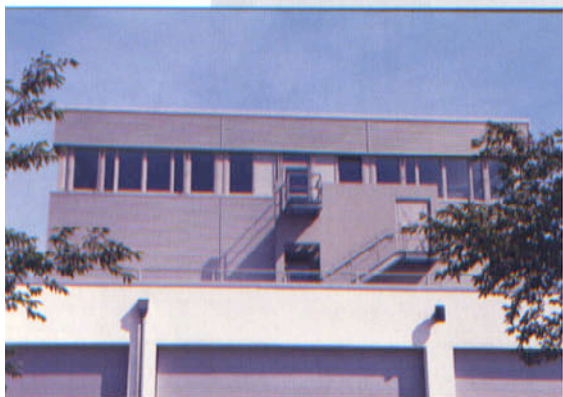
Fassadenverkleidung mit Aluminiumblechen
