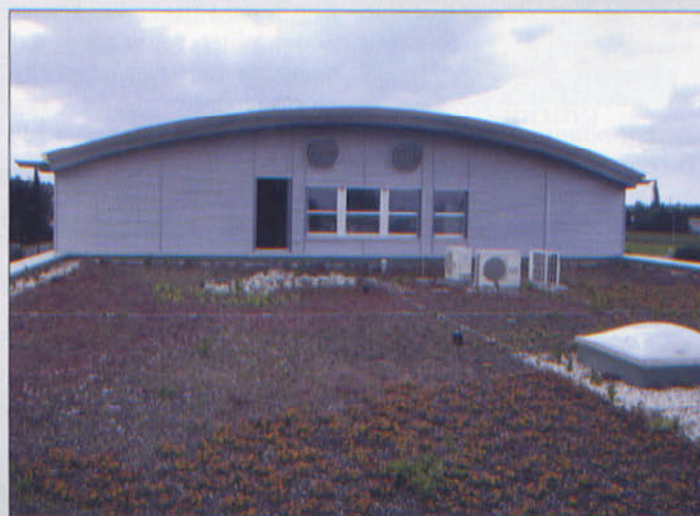
Flachdach mit einer Kombination von extensiver Begrünung und Lichtkuppeln
